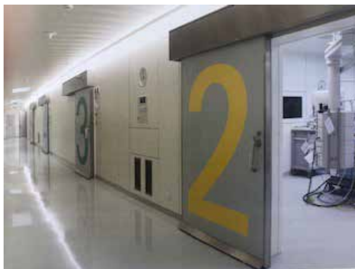
Figura 14.4 - Illuminazione di un percorso di accesso alle sale operatorie. Clinique des Grangettes Ginevra. Prog. Les architectes Associés
