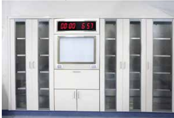
Figura 16.21 - ATOS parete attrezzata di Sala operatoria
