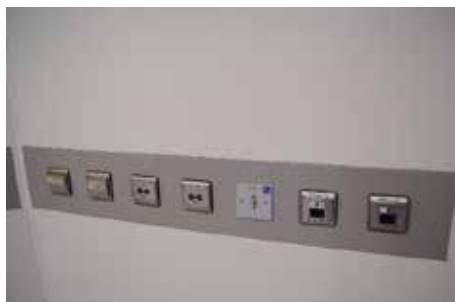
Figura 16.14 - Sanitario - dettaglio del pannello porta utenze - Figura 16.15 - Dettaglio di integrazione tra telaio porta e pannello parete - Figura 16.16 - Dettaglio guarnizione e fissaggio pannelli
