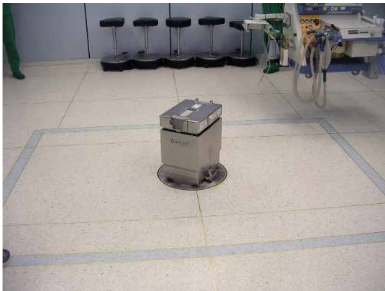
Figura 16.3 - BG Klinik Ludwigshafen di Francoforte – Pavimentazione della Sala operatoria
