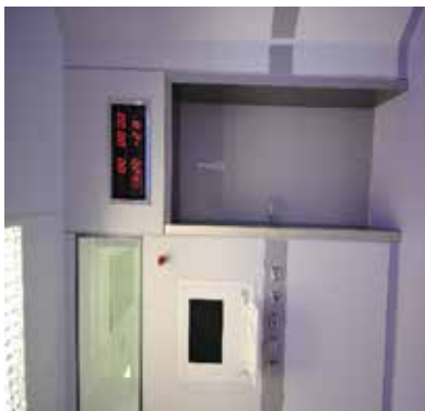
Figura 16.22 - AOU Careggi Blocco operatorio Volano Sanitario Progetto Arch. M. Moglia (Moma studio) - Orologio contasecondi - Figura 16.23 - Solari orologio contasecondi per Sala operatoria con misurazione temperatura e umidità
