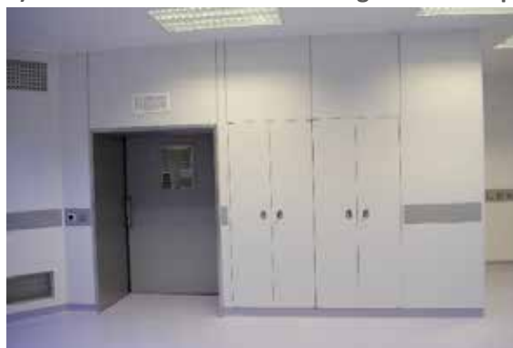
Figura 16.13 - Azienda Ospedaliero Universitaria Careggi Blocco operatorio Volano Sanitario Progetto Arch. M. Moglia (Moma studio) – vista delle armadiature integrate e della porta d'ingresso
