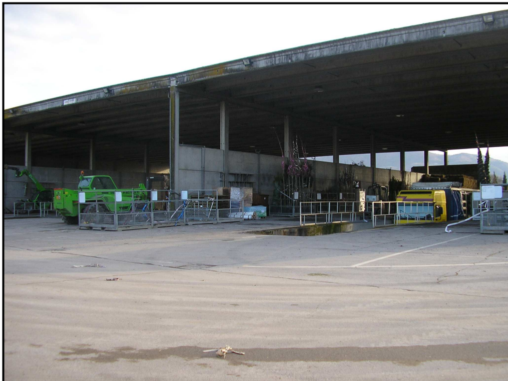
Fotografia 7 - Piazzale di carico con banchine attrezzate
