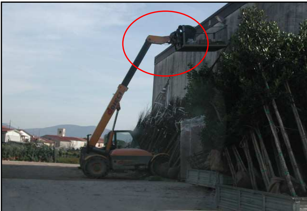
Fotografia 32–Uso improprio del carrello (sollevamento cesta con operatore a bordo)
